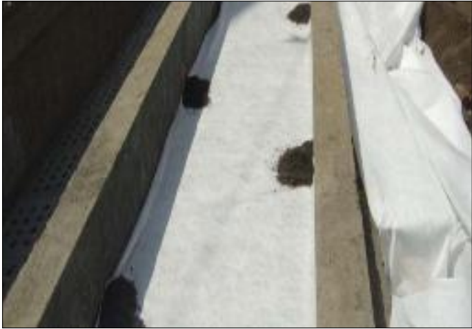
Fig 3 & 4 : Laying of TechGeo - NG2
