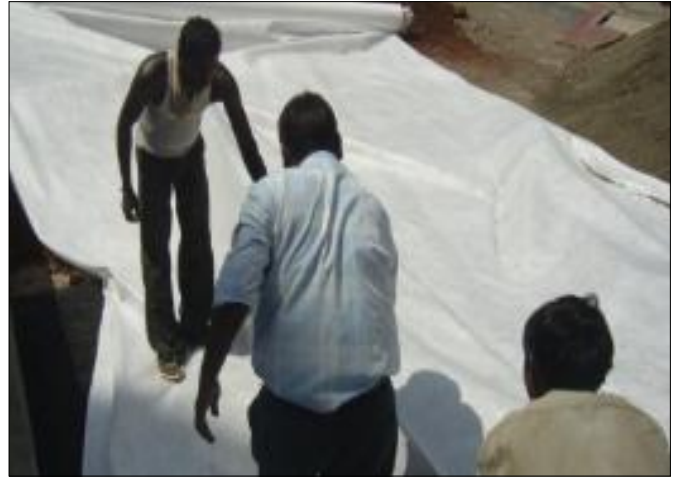
Fig 3 & 4 : Laying of TechGeo - NG2
