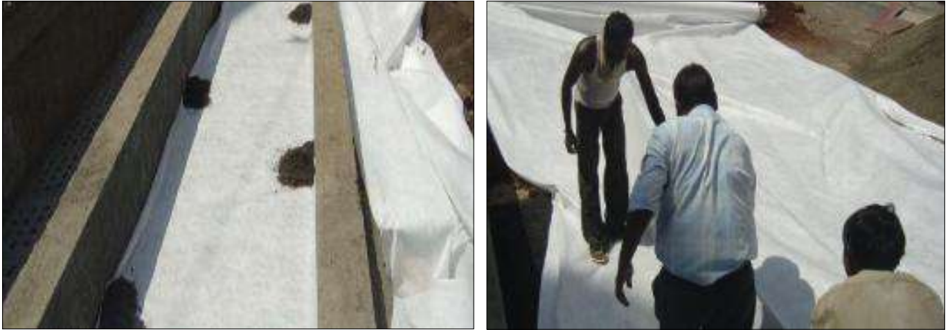
Fig 3 & 4 : Laying of TechGeo - NG2
