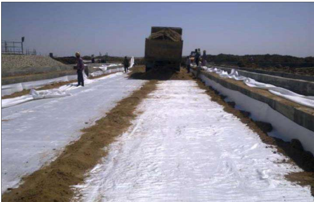
Fig 7 : Sand layer over TFI-3100 Woven Polyester
