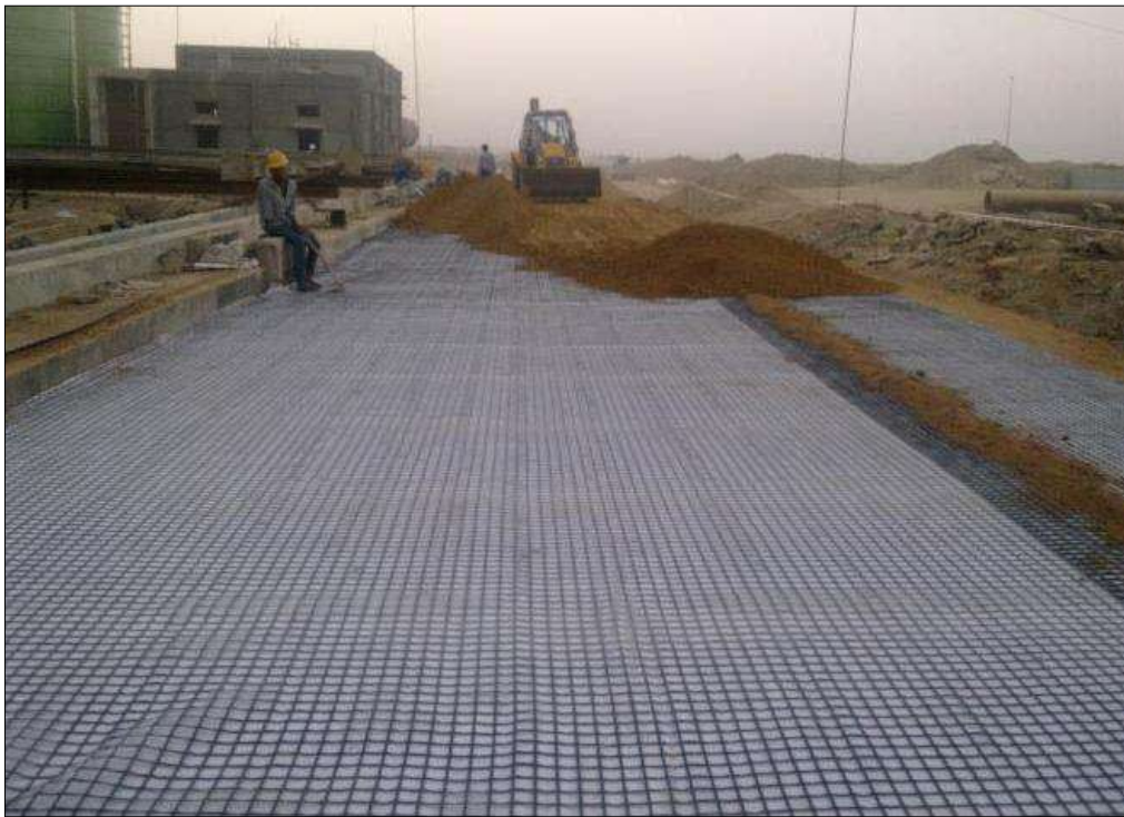
Fig 6 : Sand Layer over Techgeo PR & TGB
