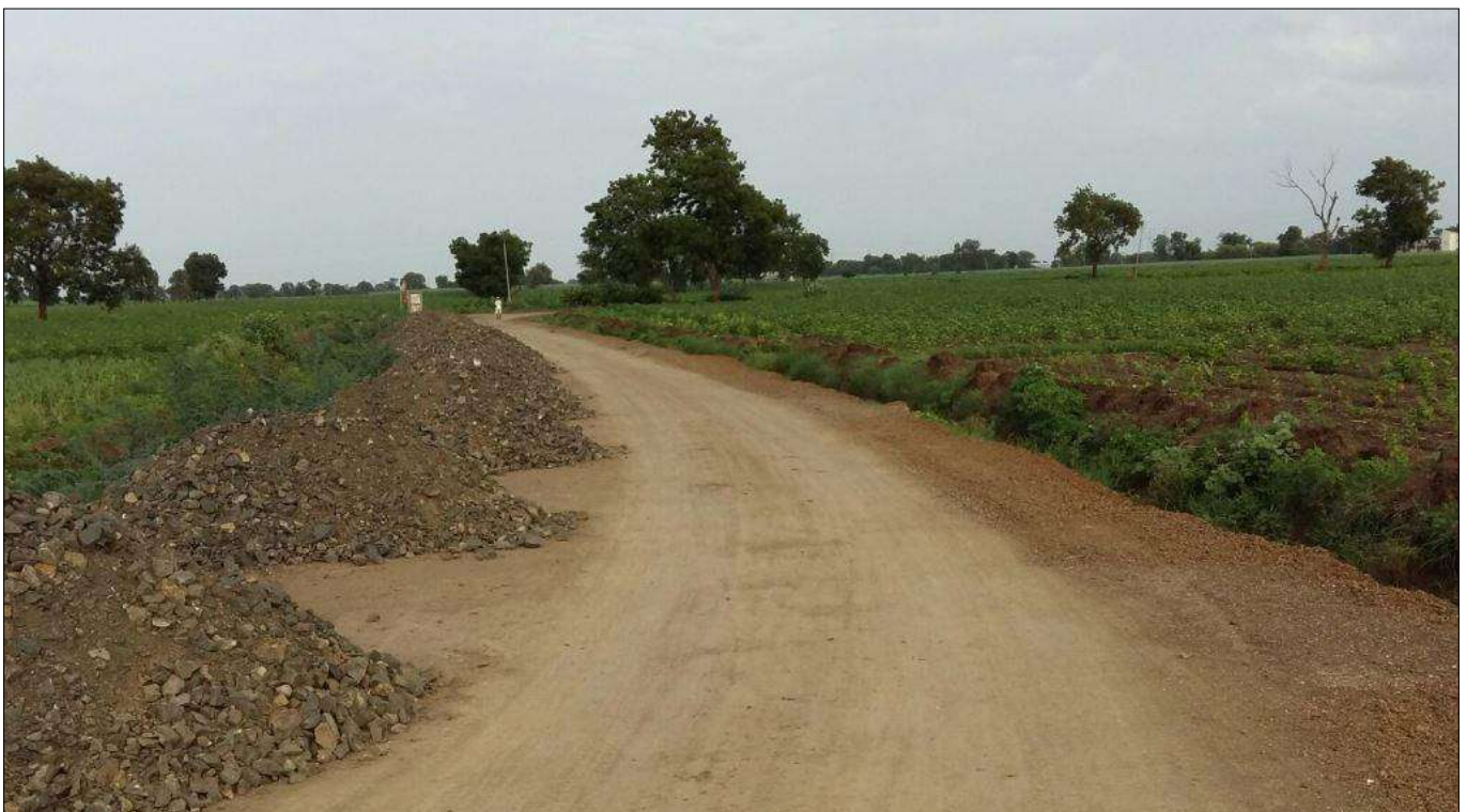
Photo 6 : GSB Layer over Sand Layer
