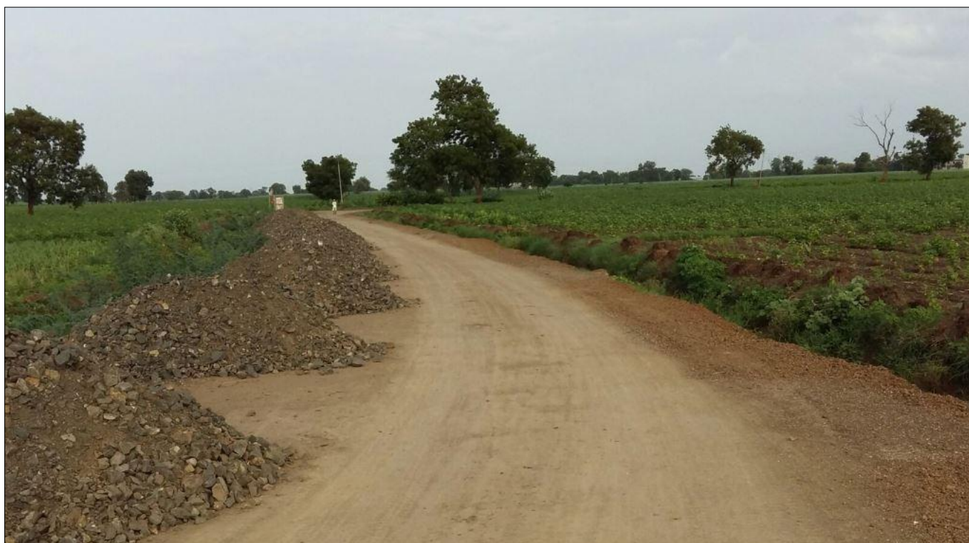
Photo 6 : GSB Layer over Sand Layer
