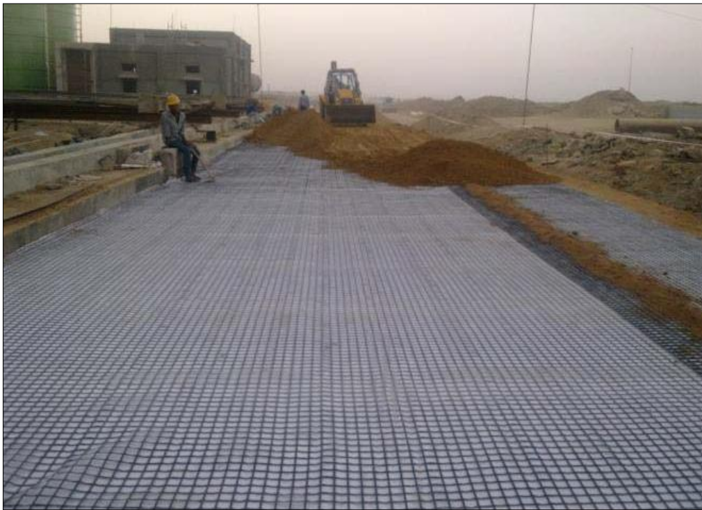
Fig 6 : Sand Layer over Techgeo PR & TGB
