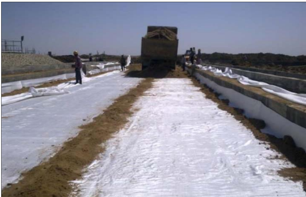
Fig 7 : Sand layer over TFI-3100 Woven Polyester
